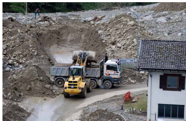
Aufräumarbeiten in Kappl – Lochau
